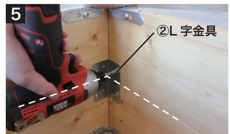
ラック上部の内側から L 字金具で固定。木材の連結部分 (中心) をまたぐように固定する。反対側も同様に固定する。
