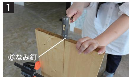
写真のように木材 A を 2 枚横並びにし、なみ釘で連結させる。(反対側も連結)
