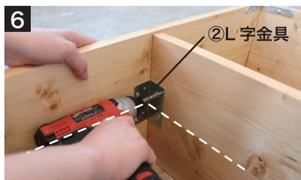
棚の高さが均等になる位置に棚板 (A-5) を固定。L 字金具で木材の連結部分 (中心) をまたぐように固定する。反対側も同様に固定する。
